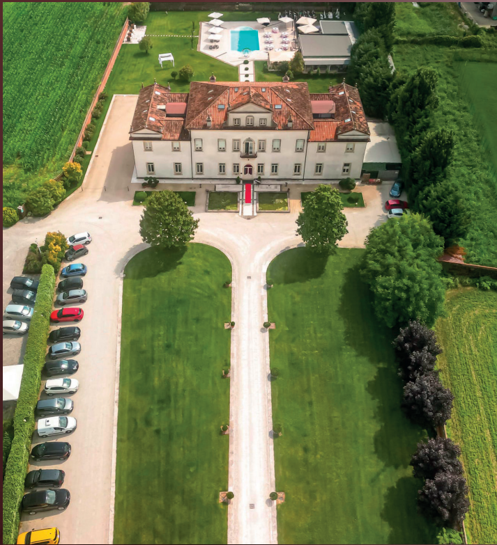
LATO NORD INGRESSO
